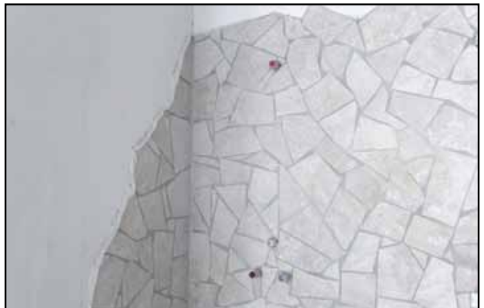
Leider können wir Ihnen noch kein Bild der fertigen Duschecke präsentieren, da bei Redaktionsschluss die Fliesenleger noch mitten bei der Arbeit waren.
