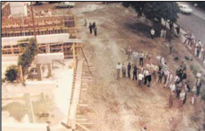
Richtfest am 23. Juni 1973, vorher war hier eine große Wiese.
