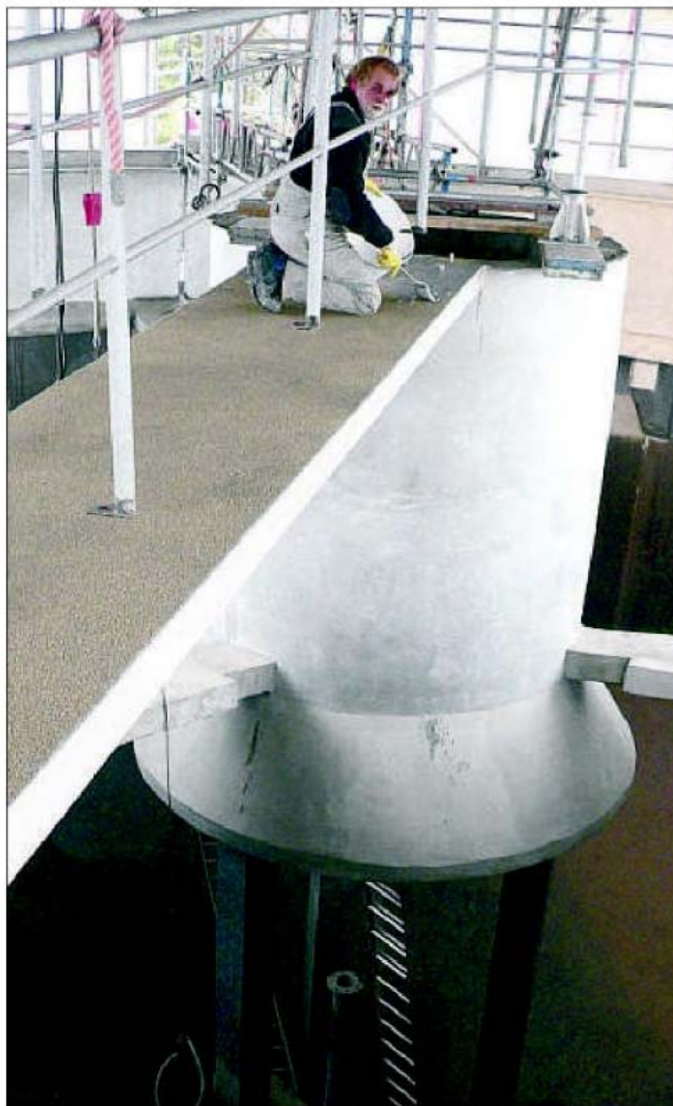
Rainer Jacobsen von der Firma Greve und Greve bringt eine Kunststoffbeschichtung auf den Beton im Schlammstapelbehälter des Schneverdinger Klärwerks auf – unter ihm geht es etwa zehn Meter in die Tiefe.
