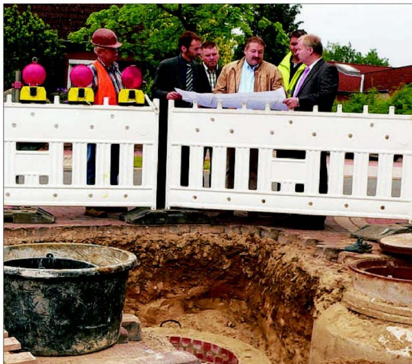
Baubesprechung im abgesperrten Einmündungsbereich Kabenstraße/Kantor-Kruse-Straße mit (von links) Polier Günther Broszeit, Neuenkirchens Bürgermeister Carlos Brunkhorst und Bauamtsleiter Bernd Pomian, Bauleiter Uwe Quante, Firmenchef Volker Vehlow und Stadtwerke-Prokurist Stefan Lamping. Foto: vo
