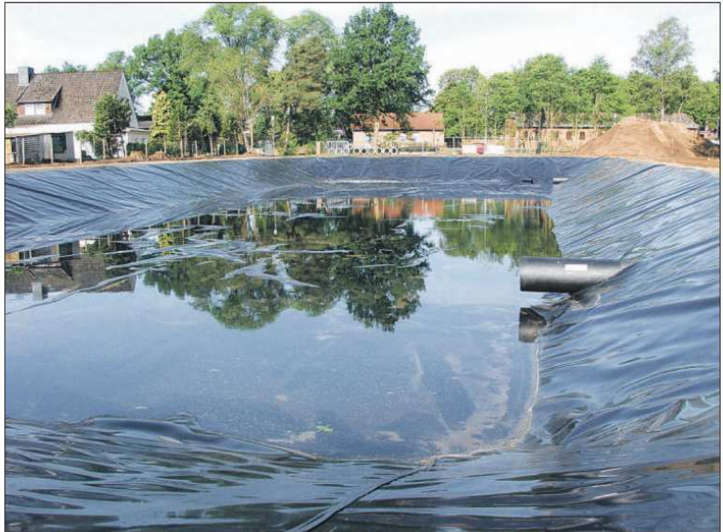
Das neue Regenwasserrückhaltebecken am Heidkampsweg hat ein Fassungsvermögen von 1600 Kubikmetern.
