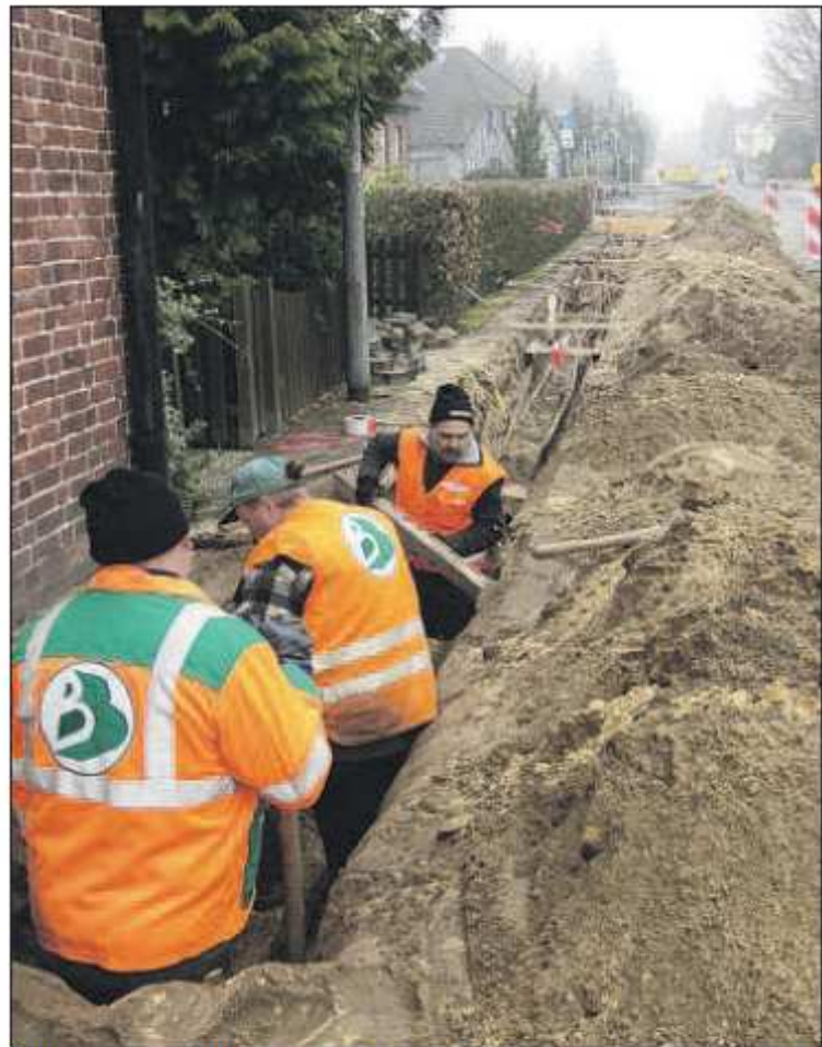
Arbeiter der Walsroder Firma Bartz erneuern derzeit in der Bergstraße die Wasser- und die Niederspannungsleitung im Auftrag der Stadtwerke Schneverdingen. Foto: len
