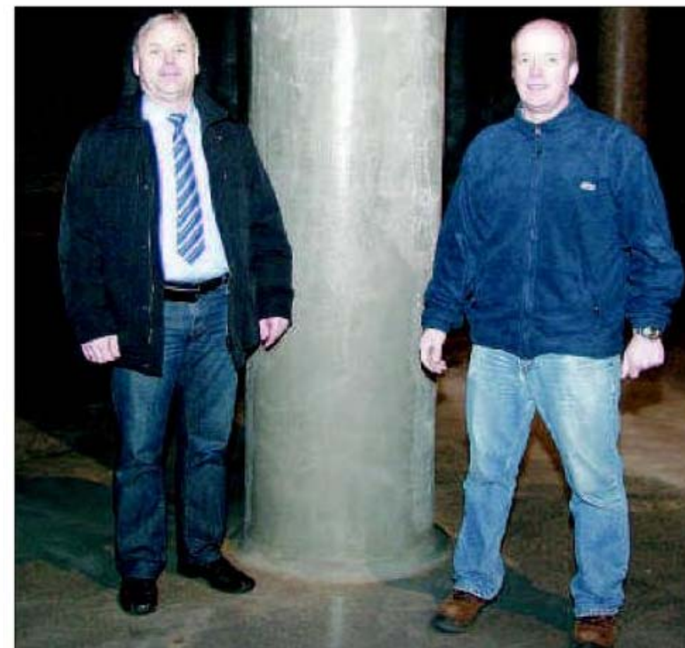
Stadtwerke-Prokurist Stefan Lamping (links) und Wassermeister Dirk Frese in einem Trinkwasserhochbehälter im Höpen. Foto: len
