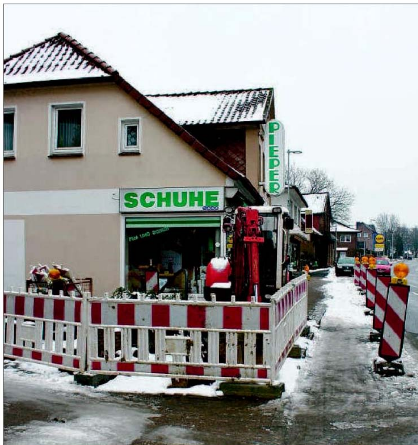
In der vergangenen Woche war die Firma Schröder schon dabei, die Wasserleitungen in der Harburger Straße auf Höhe des Schuhhauses Pieper zu erneuern. Momantan stehen die Arbeiten jedoch wegen der kalten Witterung still. Foto: rdv
