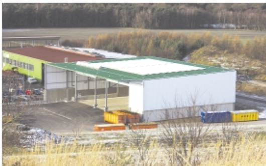
Deponie Hillern: Blick auf die neue Umschlaghalle mit - eisbedeckter - Photovoltaik-Anlage auf dem Dach.
