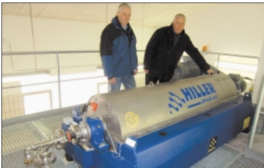
Präsentieren die neue Entwässerungsanlage: Klaus Wiebusch (li.), Betriebsleiter der Kläranlagen Schneverdingen und Neuenkirchen, sowie Wolfgang Rosenbrock von der Stadt Schneverdingen.
