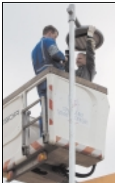
Am Montag begannen Arbeiter mit der Montage.
